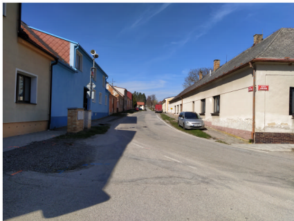
Ulice Jana Koláře před začátkem rekonstrukce
