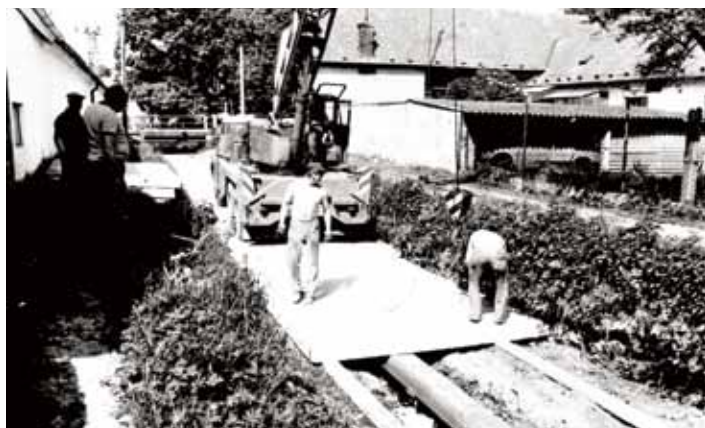
Zatrubnění bukovského potoka dokončeno v roce 1991
